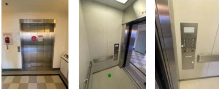
Figure 19. Images des ascenseurs
